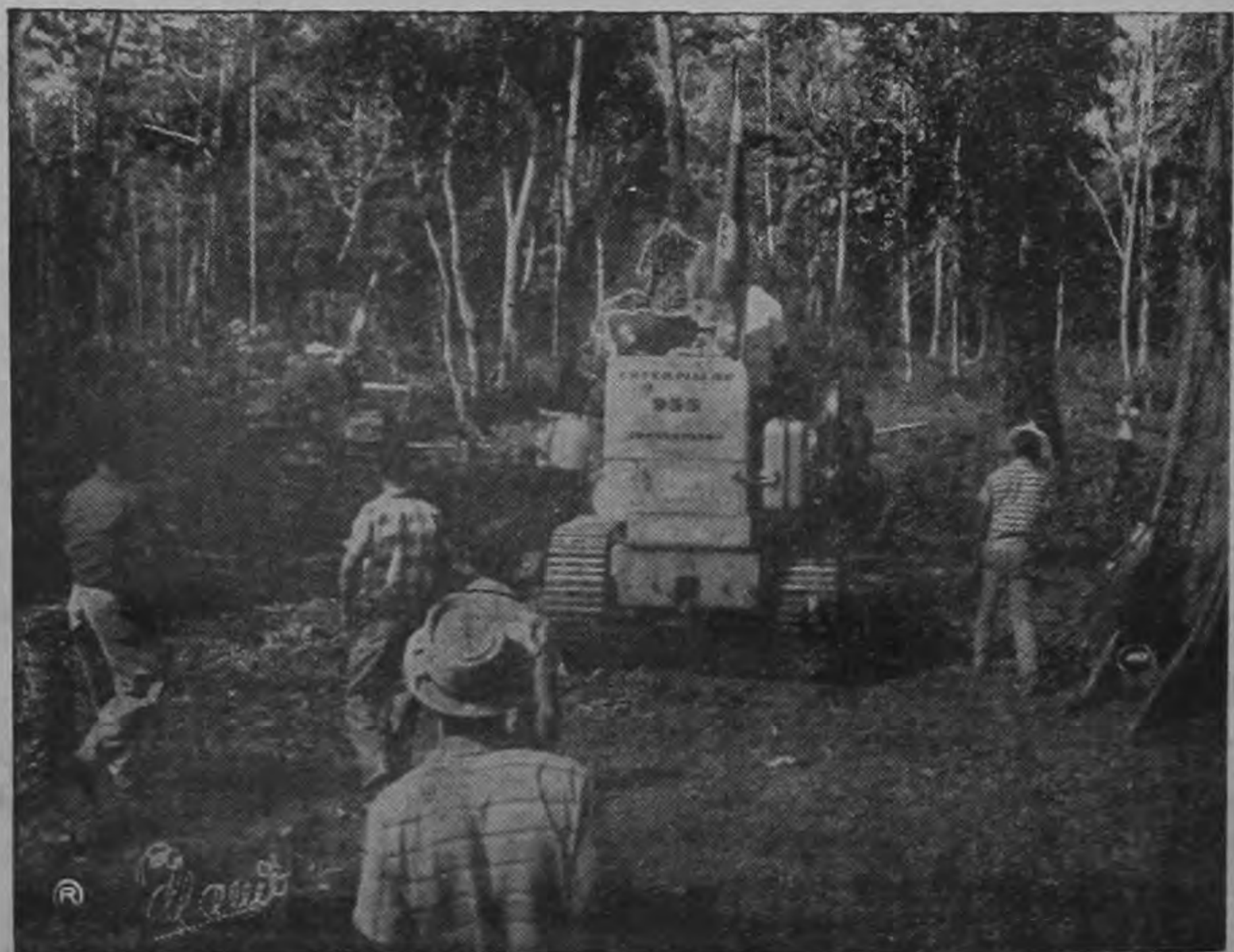
Como acto final de la ceremonia de colocación de la primera piedra de la Refinadora, los tractores comienzan a derribar árboles y a limpiar los terrenos en que se instalarán las plantas
